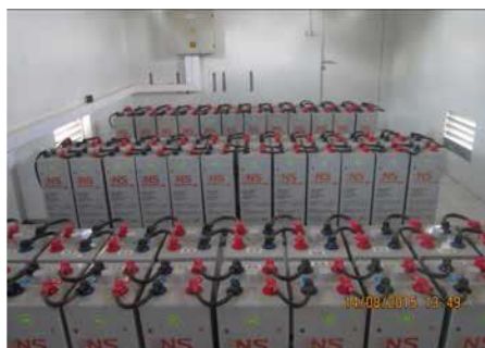
ब्याट्री स्ट्रिङहरू (Battery strings) zig-zag तरिकामा र भेन्टिलेसन (Ventilation) को साथमा प्रत्यक्ष सूर्यको जोखिमबाट बच्न स्थापना गरिएको
