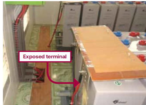
कार्डबोर्डको प्रयोगले ब्याट्री टर्मिनलहरू ढाक्ने गरेको छ । अस्थायी समाधान टर्मिनलहरू अलग गर्न पर्याप्त छैन ।
