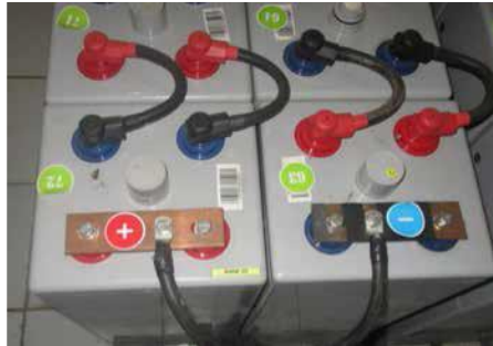
ब्याट्री टर्मिनल राम्रो अवस्थामा भएको (खिया वा सल्फेट फ्लेक्स (Sulphate flakes) बाट मुक्त)
