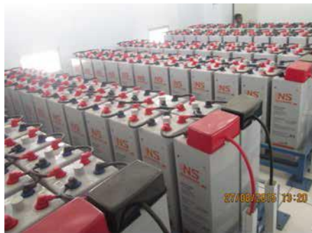
ब्याट्री टर्मिनल राम्रो अवस्थामा भएको (खिया वा सल्फेट फ्लेक्स (Sulphate flakes) बाट मुक्त)
